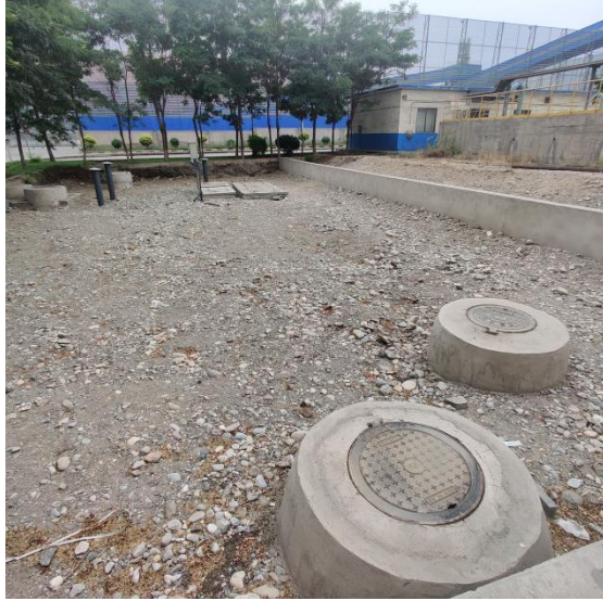
初期雨水收集池
