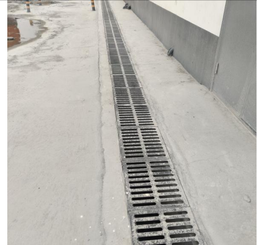
厂区雨水收集槽
