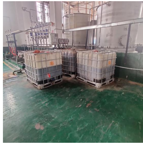
有机废水储罐
