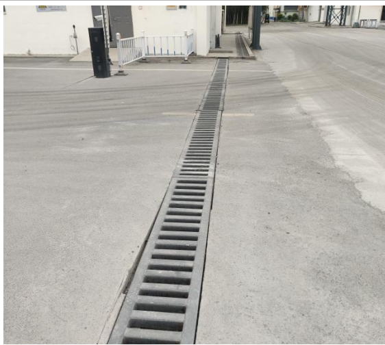
厂区雨水收集槽
